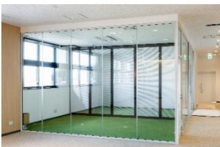
※写真手前が A、奥が B（施工中イメージ）
